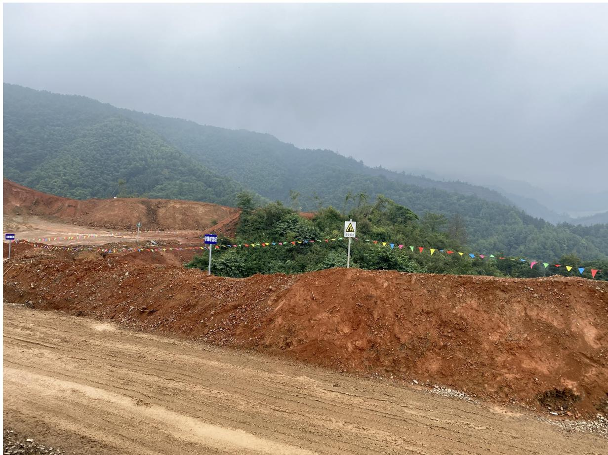
图 2-6 非爆破区域桩线及警示标志牌
